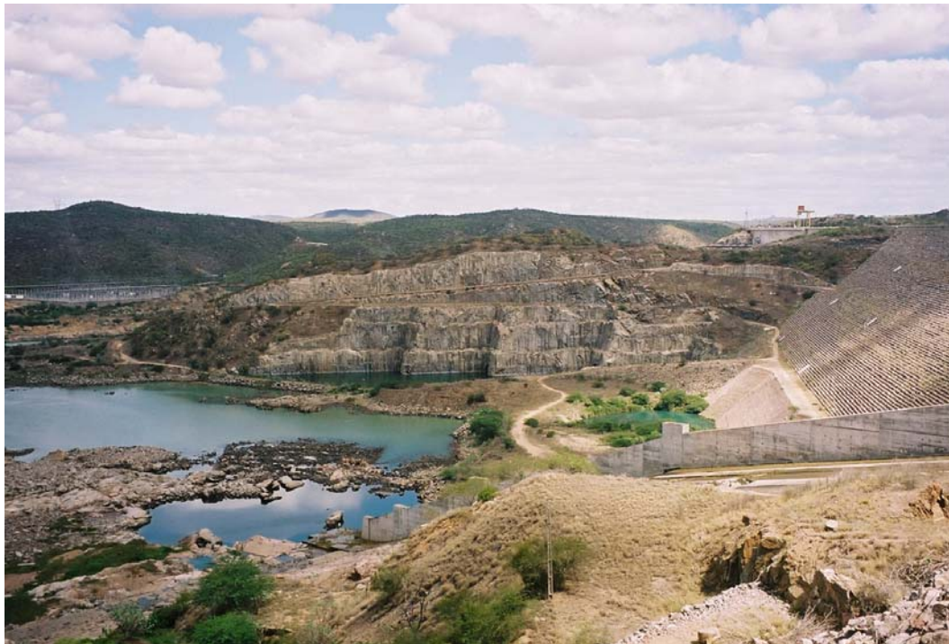
Foto: Barragem de Xingó
