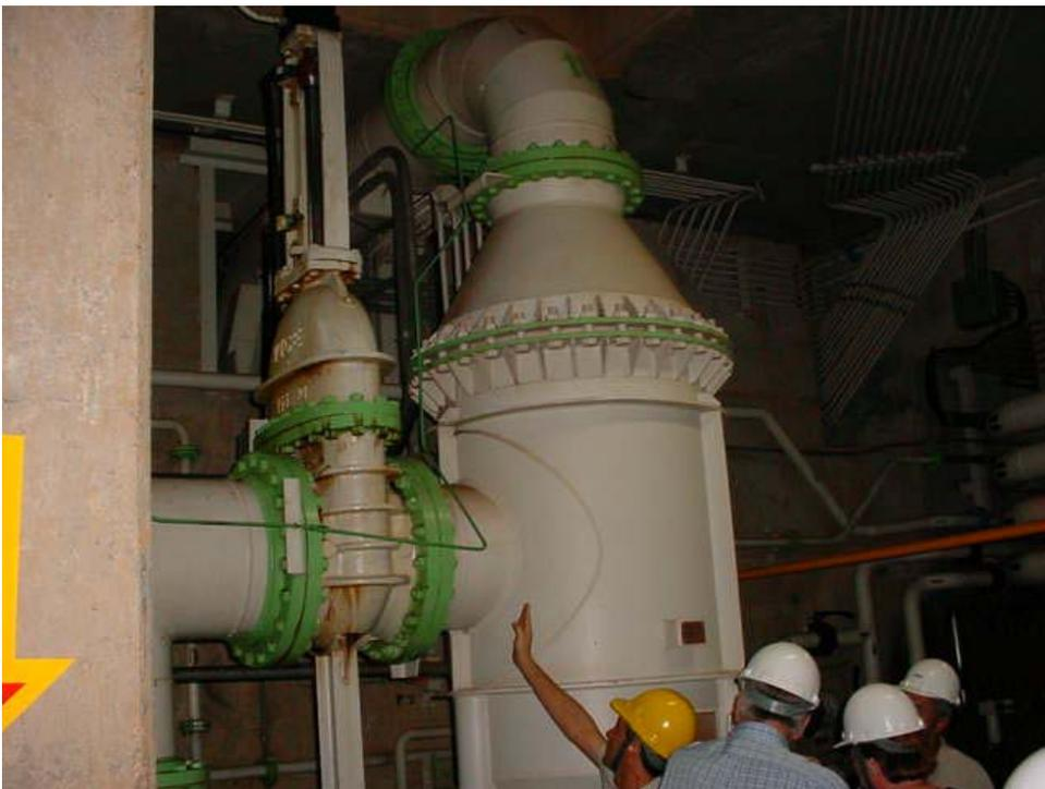
Figura 4 - Filtro de água. Entrada por cima e saída por baixo.
