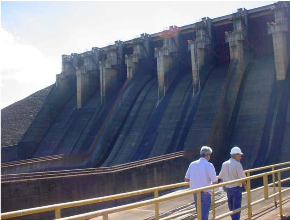
Figura 1 – O vertedouro de concreto da barragem de São Simão
