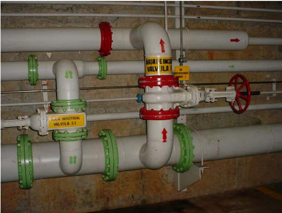
Figura 5 – Tubulação de água de incêndio (vermelhos) diferente do de água comum (verde).
