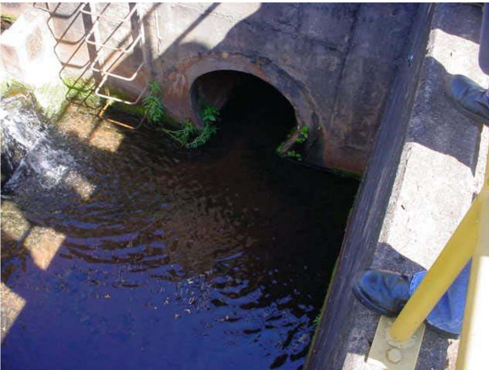
Figura 6 – Drenagem de tubulações no pé da barragem.
