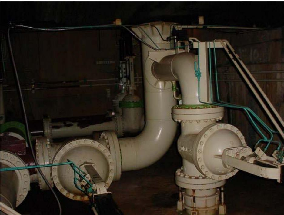
Figura 2 – Entrada da água da comporta (ela é a tubulação grande e preta no topo a foto)
