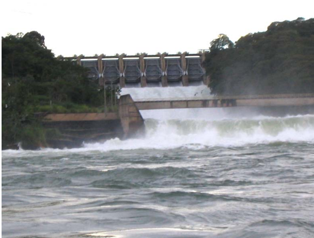
□ Imagem 1. As comportas abertas do Reservatório. Observa-se a extrema turbulência no momento em que as águas do reservatório se encontram com o Rio São Francisco na base dos jatos d'água.
