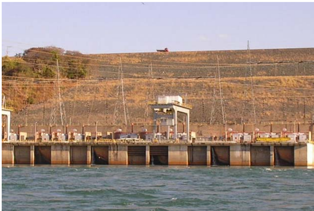
Figura 1. Barragem da Hidrelétrica de Três Marias, Três Marias – MG.
